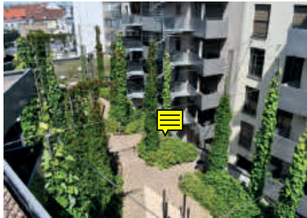
Abb. 11: Bodengebundene Fassadenbegrünung, hier mit Kletterhilfen. Quelle: BuGG
