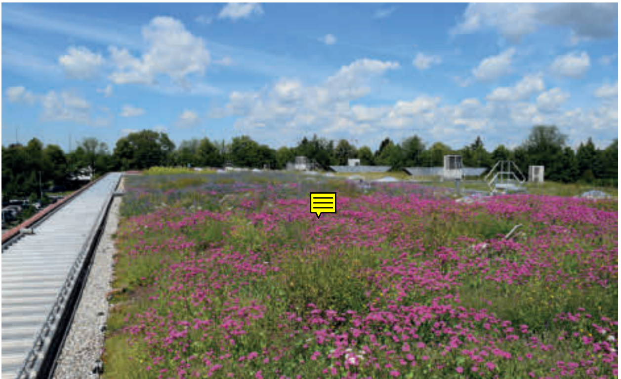
Abb. 10: Extensive Dachbegrünung, hier als Biodiversitätsdach. Quelle: BuGG
